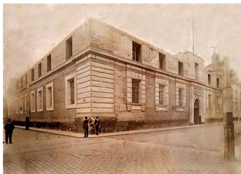
El edificio de la Biblioteca tal como comenzó a ser reconstruido por el arquitecto Manuel Julián de San Martín
